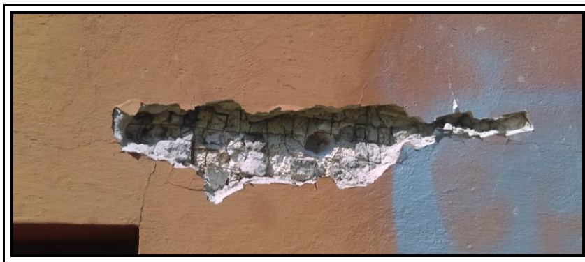
Fot. 2. Widok odkrywki ścian piwnic.
