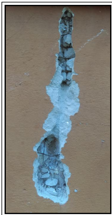
Fot. 3. Widok odkrywki ścian piwnic.
