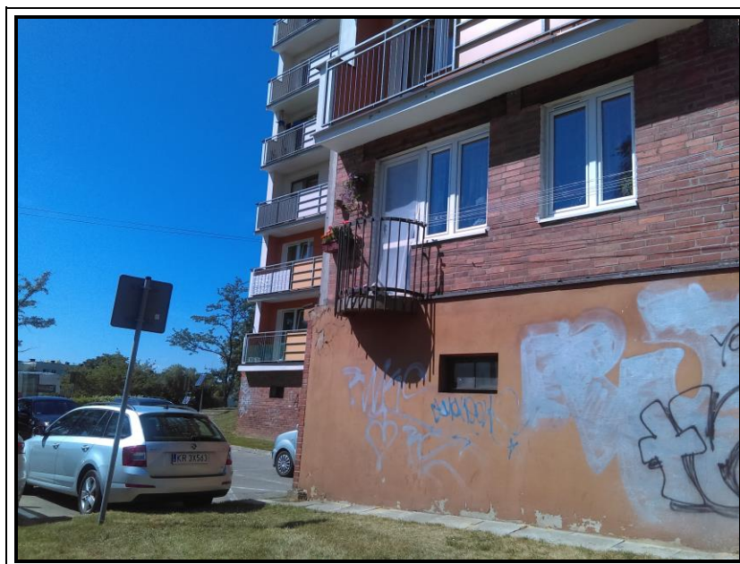
Fot. 4. Widok ścian piwnic i parteru, balkon nr 3 (wg projektu architektury).
