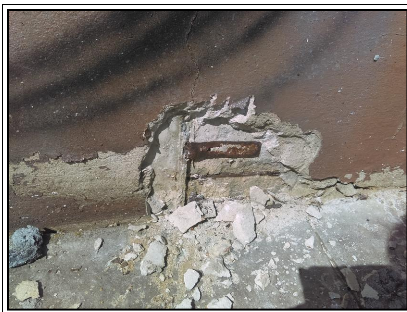
Fot. 1. Widok odkrywki ściany fundamentowej.
