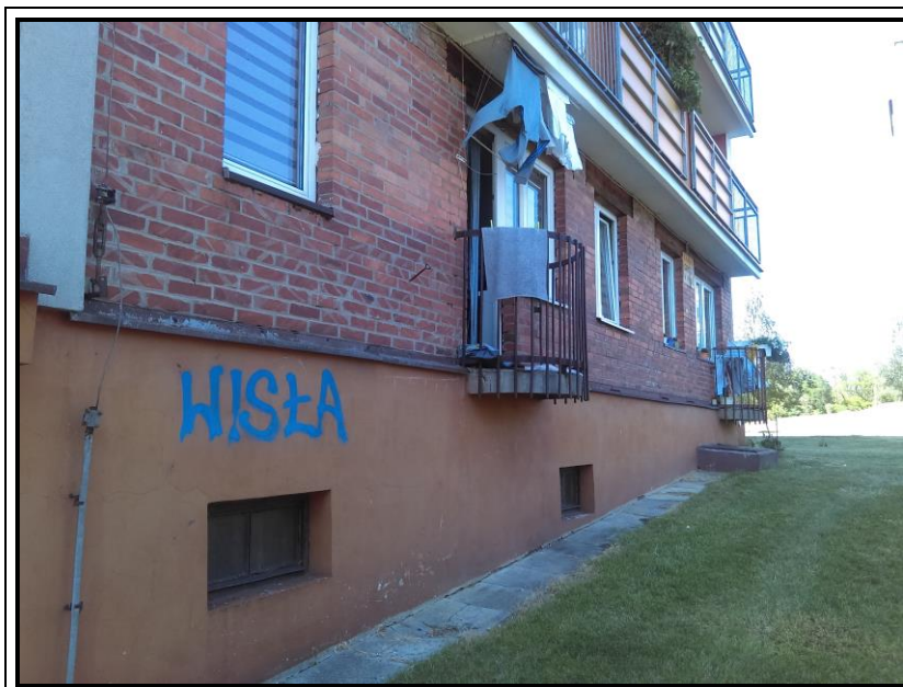
Fot. 5. Widok ścian piwnic i parteru, balkony nr 1 i 2 (wg projektu architektury).
